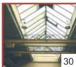
30 ·2 x Zweiträger- Brückenkran / double beam travelling crane STAHL , 16000 kg x 11000 mm ·2 x Zweiträger- Brückenkran / double beam travelling crane KAMO , 10000 kg ·ca. 15 Hallenkräne / cranes STAHL 500 - 5000 kg
